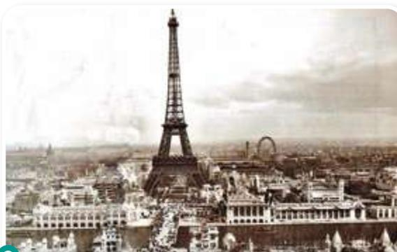
Fotografía de la Torre Eiffel en 1914. Esta estructura realizada en hierro, de 300 metros de altura, fue construida en 1889 para celebrar el centenario de la Revolución Francesa.
