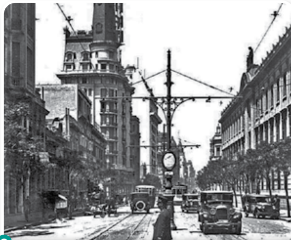
Vista de la avenida Callao y Tucumán en la Ciudad de Buenos Aires (1925).
