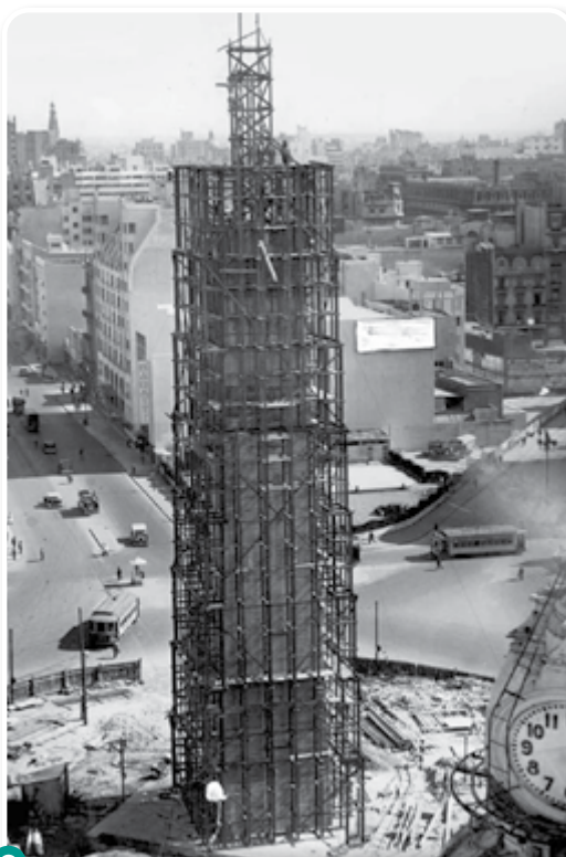
Obelisco en construcción (1936).
